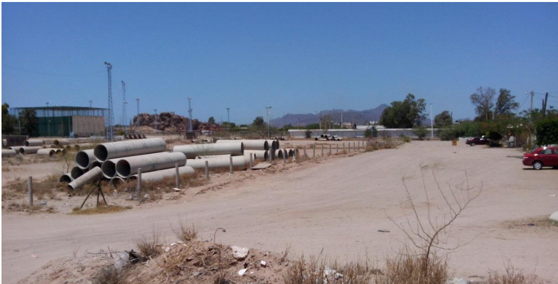
Figura 3: Trabajos de topografía del kilometraje 5+800 hacia 8+040.
