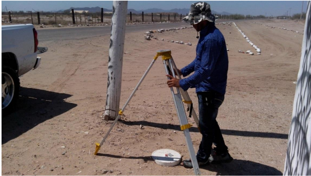
Figura 6: Colocación de tripies y bases nivelantes.
