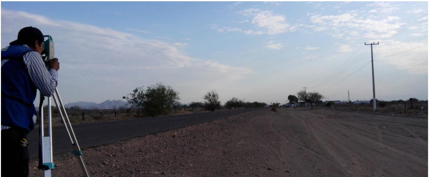
Figura 2: Trabajos de topografía del kilometraje 2+800 hacia 8+040.
